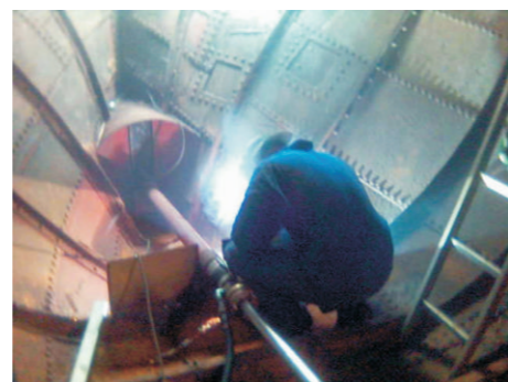
Reparatie achterschip door Rob
